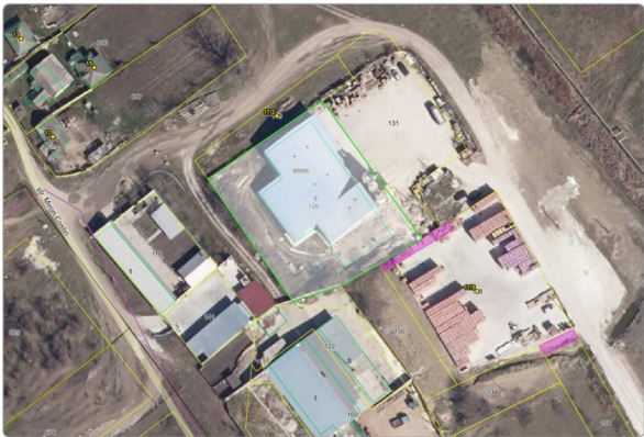
Terenul 0155213.126 (0,25 ha) cu clădirea industrială .01 (1.027,8 m²)
