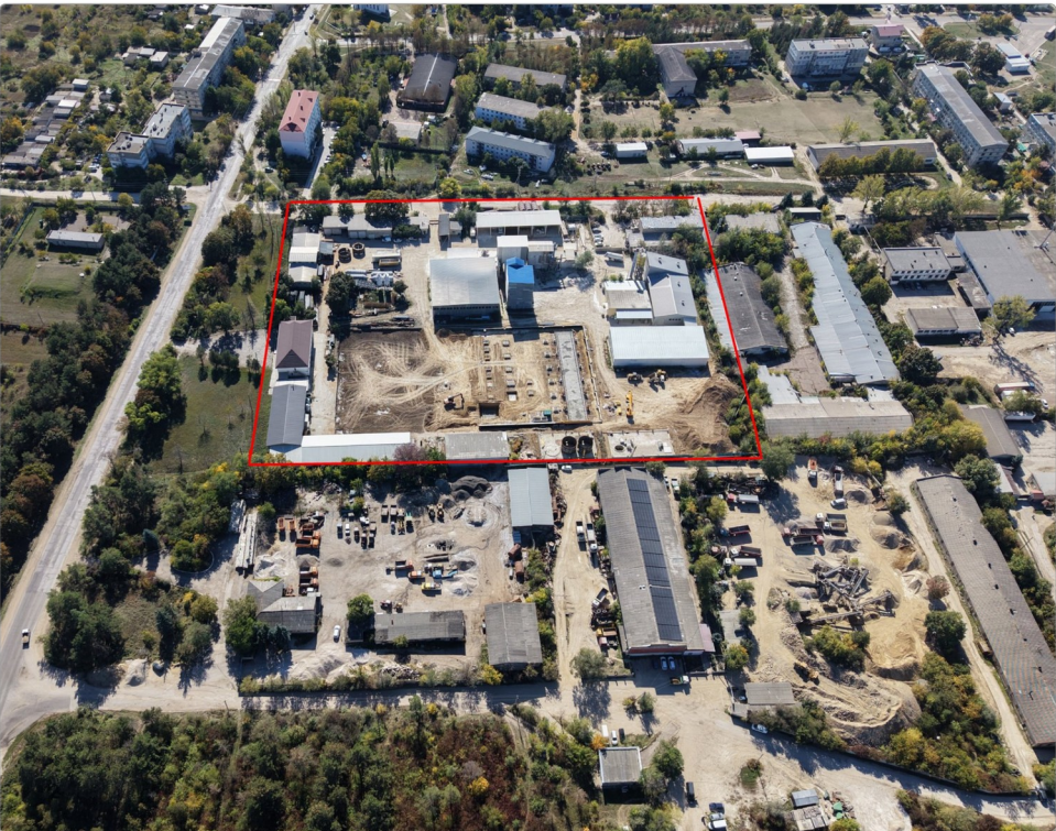
Fotografie aeriană (2026): platforma exploatată de S.R.L. „General Building”; se observă lucrări noi de construcție (fundații, săpături)
